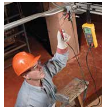
Магнитное подвесное устройство освобождает руки для безопасного проведения измерений
